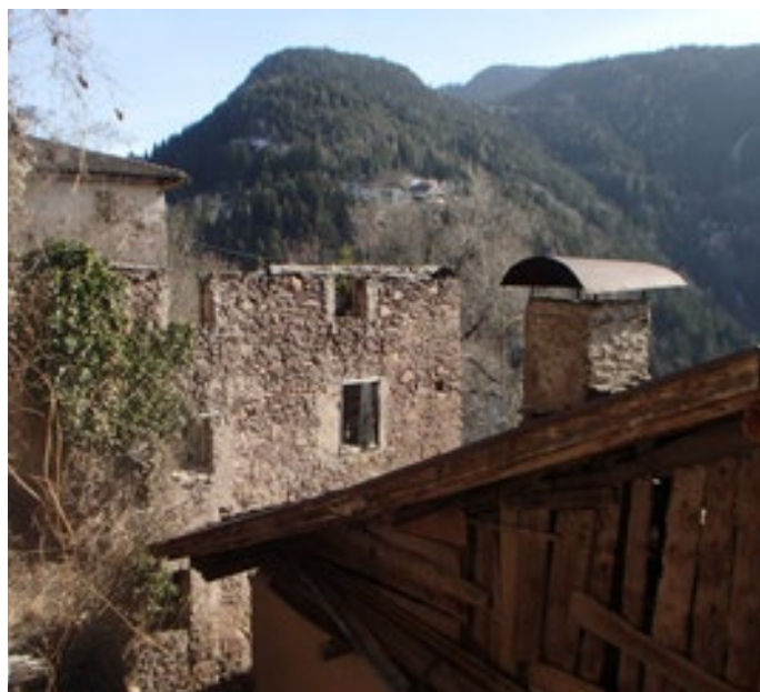
p.ed. .7/1 e .9/1 – vista nord-ovest su strada interna
