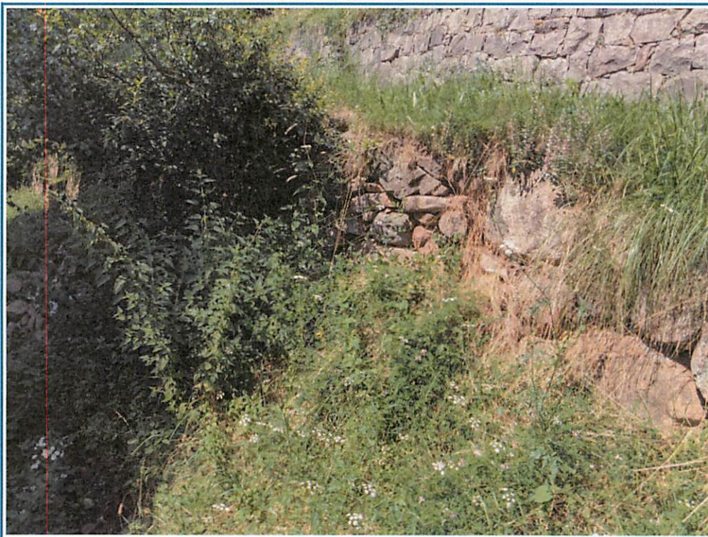
Foto 4: Particolare del muro in sasso a secco rimasto in piedi.
