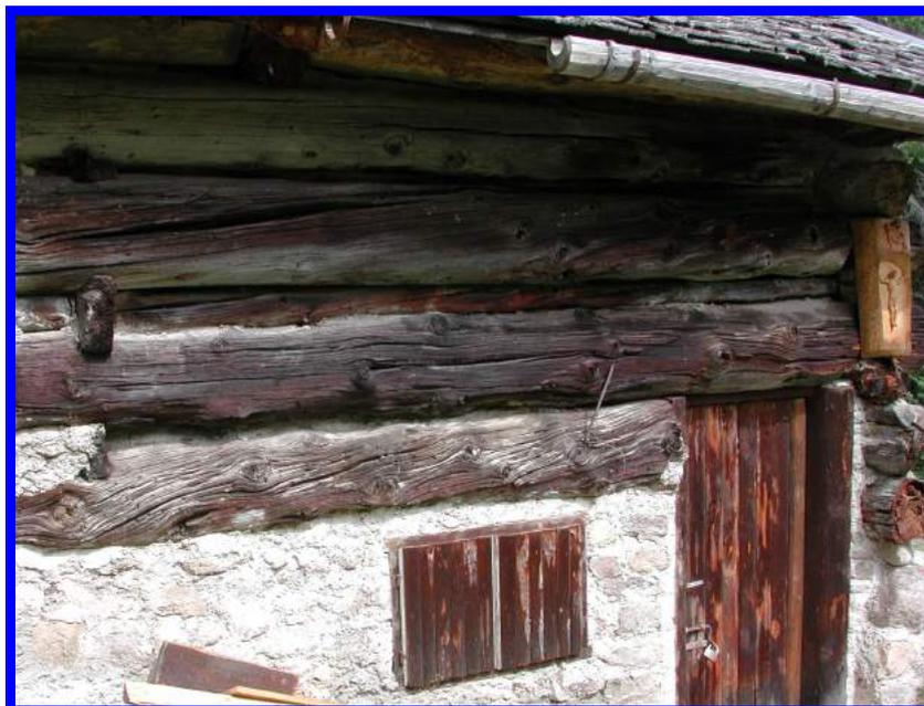
La tipica struttura in “blockbau” si esprime anche nello zoccolo al piano terra, impreziosito talvolta dalle strutture angolari a mensola aggettanti per il sostegno dell’essiccatoio superiore.
