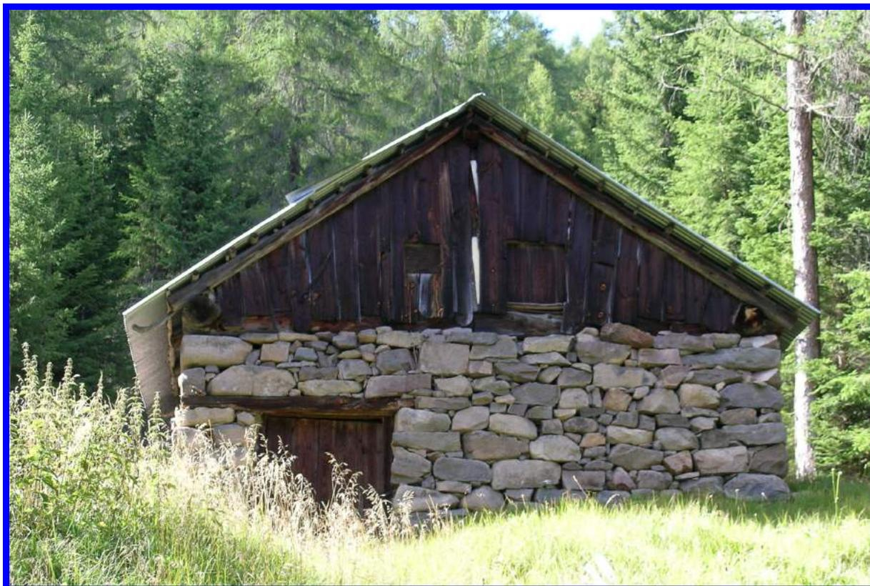
Talvolta i sassi venivano evidenziati oppure rasati con malta di calce tirata a *fratazzo di legno*, che presenta un aspetto rugoso caratteristico e che in molti casi ha lasciato a vista i sassi della struttura portante.
