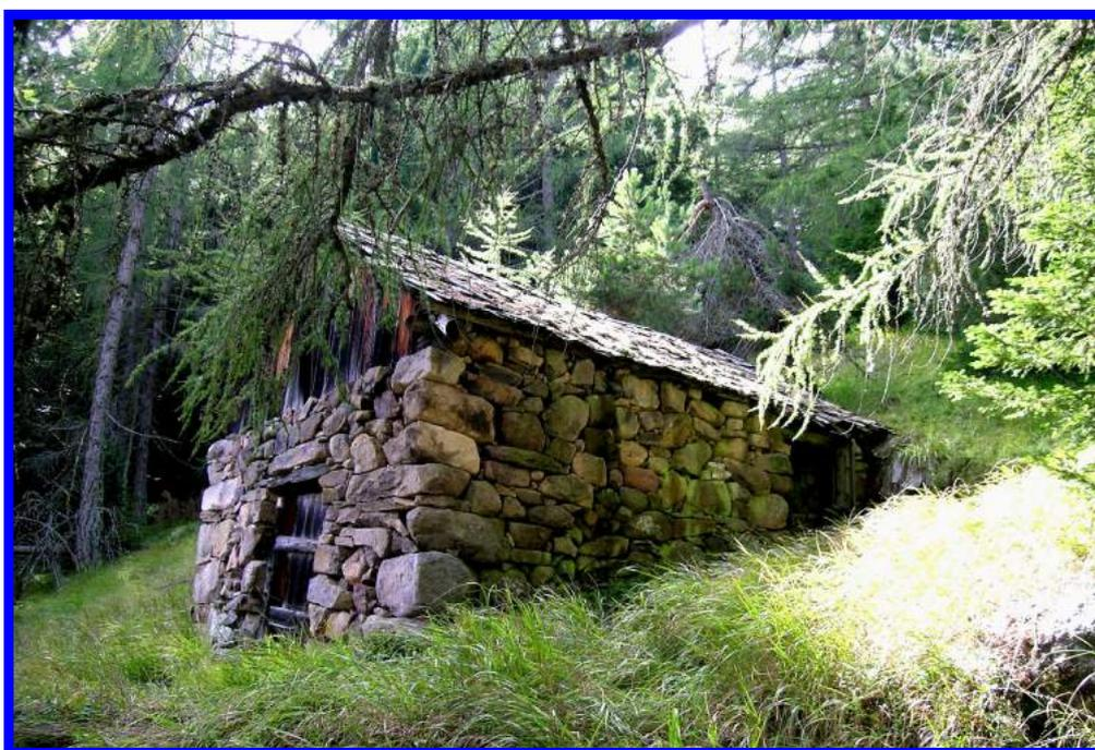
L'edificio rustico raccoglie in sé gli spazi funzionali della stalla, del fienile, dell'essiccatoio e del magazzino. Tali spazi si aggregano tra loro secondo elementari principi di ottimizzazione funzionale ed ergonomica, in stretto rapporto con il terreno in declivio.
