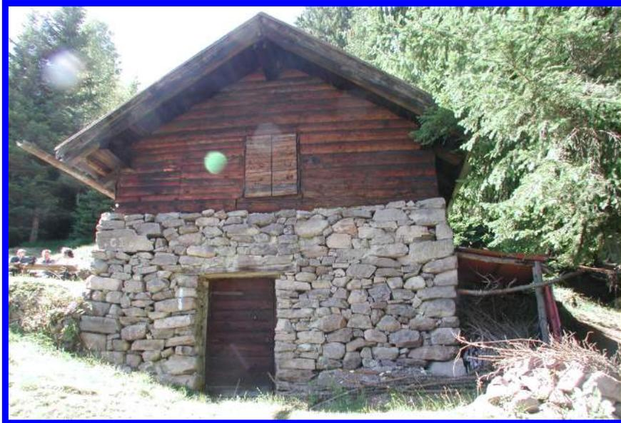
Il tamponamento sovrastrutturale in tavole grezze forma le caratteristiche facciate lignee, in cui appare spesso notevole il risultato di “tessitura” del tavolato, la composizione dei tagli e delle riprese, il ritmo asimmetrico dei fori e il gradevole effetto cromatico. Il ricorso alla foratura del tamponamento ligneo del fienile, risponde all’esigenza funzionale di areare il più possibile il vano destinato all’essiccazione.
